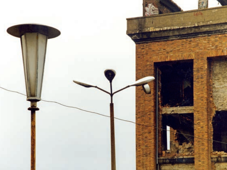
Noch im Jahre 2002 stand eine Herzog-Leuchte nahe der Koksseparation in der Schiffbauergasse. Daneben ein dreiarmer Mast mit „Bassgeigen“. Foto: Thoas Töpfer
