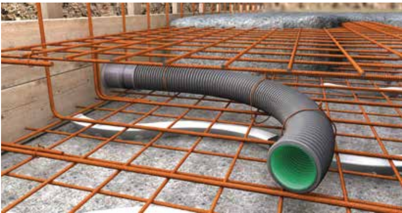
Bild 14: Elektroinstallationsrohr für Betonverlegung
