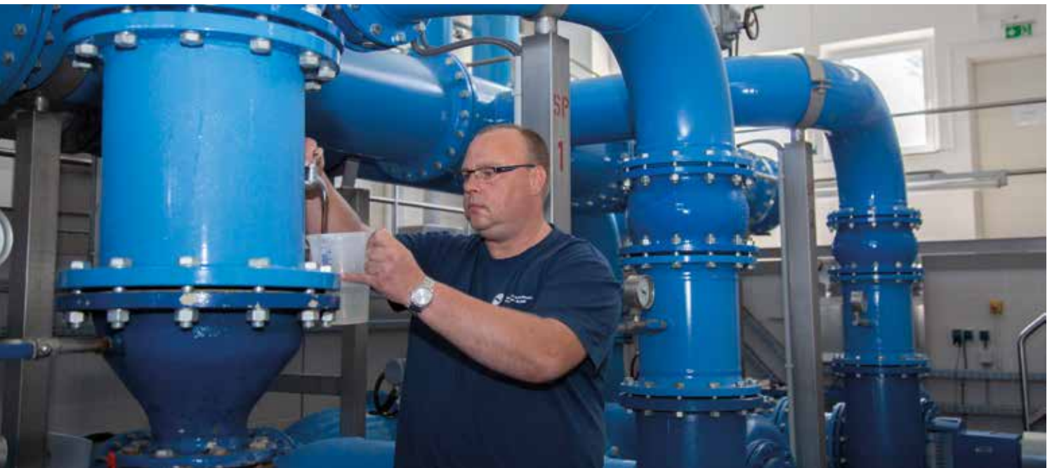
Entnahme einer Wasserprobe im Wasserwerk Rehbrücke
