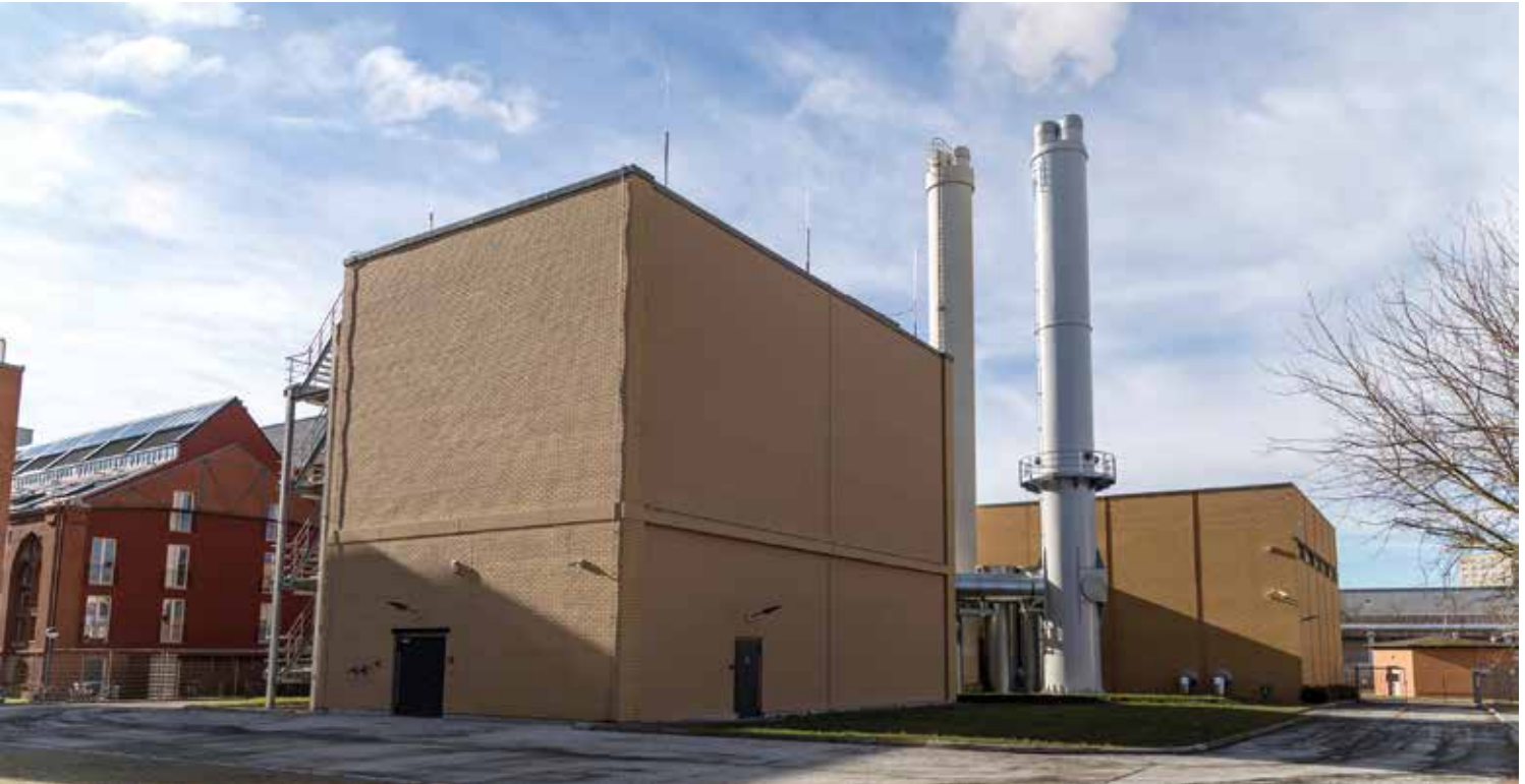
Heizwerk Nord in der Potsdamer Zeppelinstraße.
