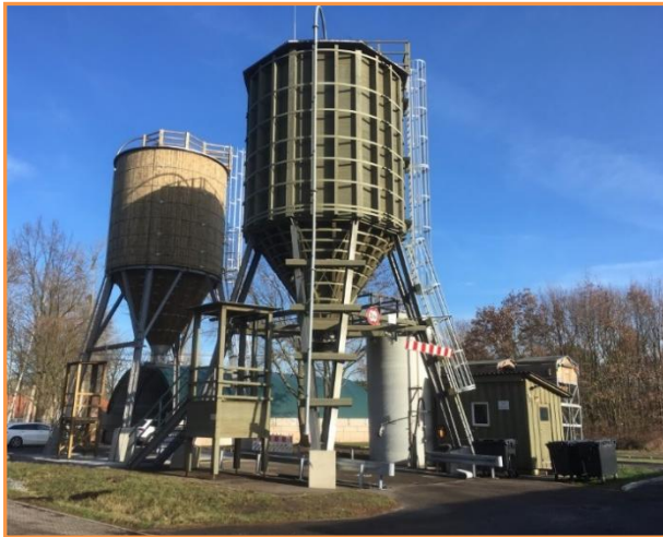
Abbildung 17: Winterdiensttechnik (2 Salz-Silos, 1 Sole-Anlage) am Standort Betriebshof Nedlitz
