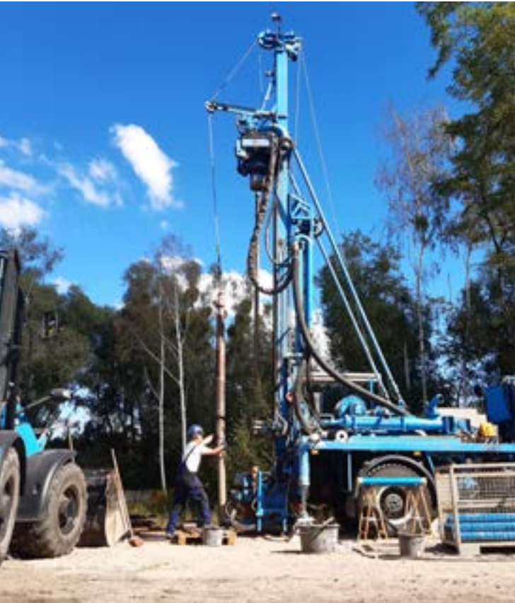
Geothermiebohrung in Krampnitz
