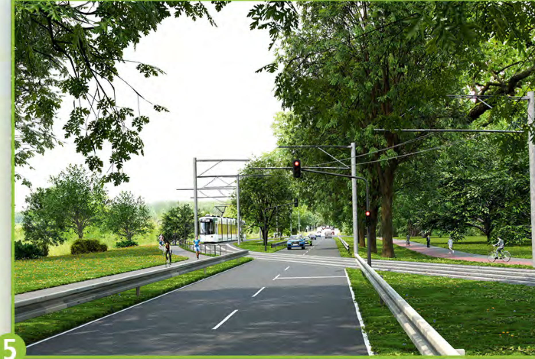
5 Tramquerung B2 im Bereich Gellertstraße
